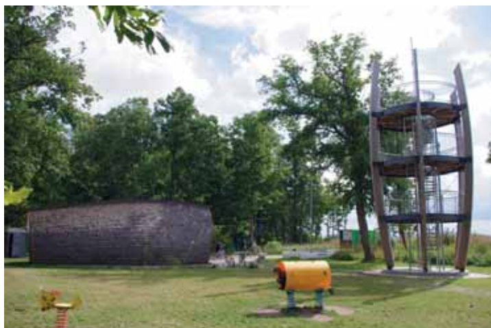
Joonis 3. Valgeranna puhkeala vaatlustorn
